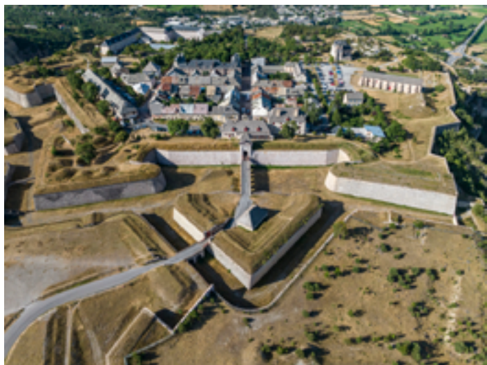
Vue aérienne du front d'Eygliers
